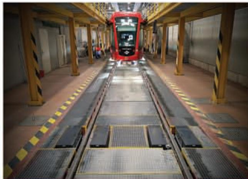
IWMS installation eines Indoor-Systems
