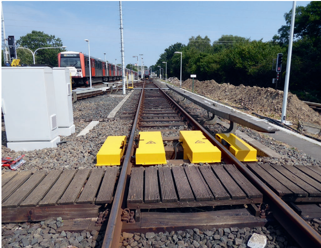
»IWMS« Outdoor-Messanlage. Bild: Hamburger Hochbahn
